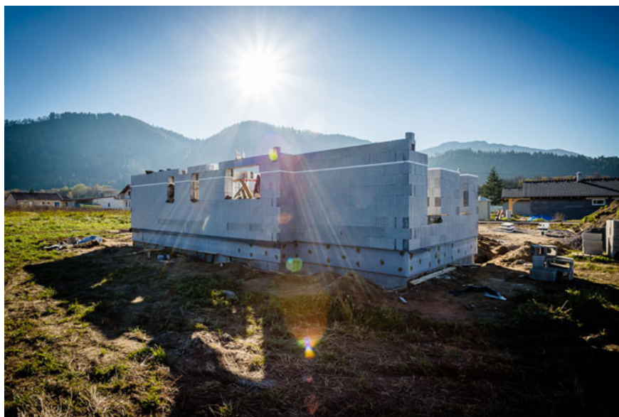
Na Slovensku sa prvý rodinný dom stavia systémom Variant-Haus v obci Podtureň, okr. Liptovský Mikuláš. Na obrázku je stavba po 38 hodinách čistého pracovného času.
